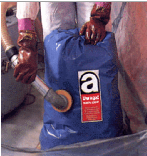
Zdjęcie nr 5. Prawidłowy sposób pakowania odpadów we właściwie oznakowane worki foliowe, ich powierzchnia zewnętrzna po zakończeniu czynności zostaje odkurzona
