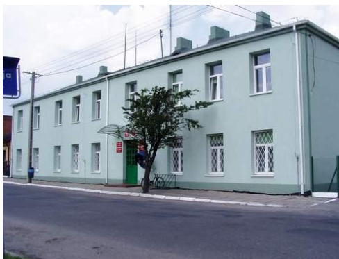
Budynek Urzędu Gminy w Rozprze
